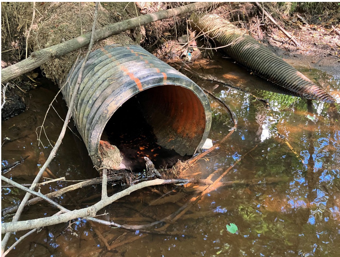
Kuva 7 Tontin länsiosan rumpu, noin \varnothing 250 mm
