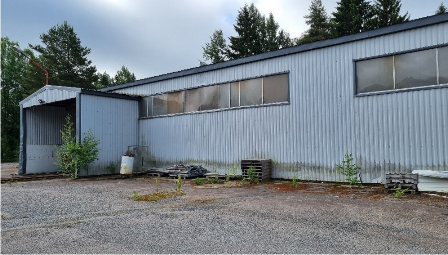
Kuva 5. Eteläisemmän hallirakennuksen pohjoissivu.
