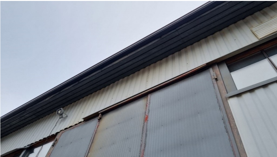
Kuva 2 ja 3. Pohjoisempi hallirakennus ulkopuolelta ja räystäään alta, kuvat eteläsivulta.
