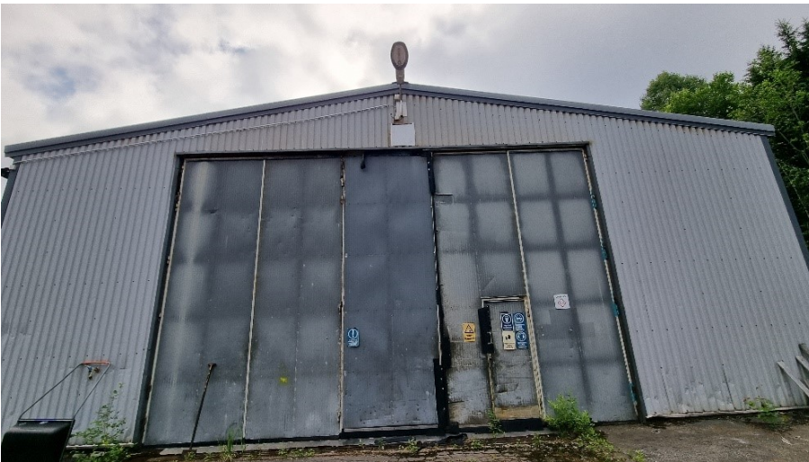
Kuva 6. Eteläisempi hallirakennus länsisivulta.
