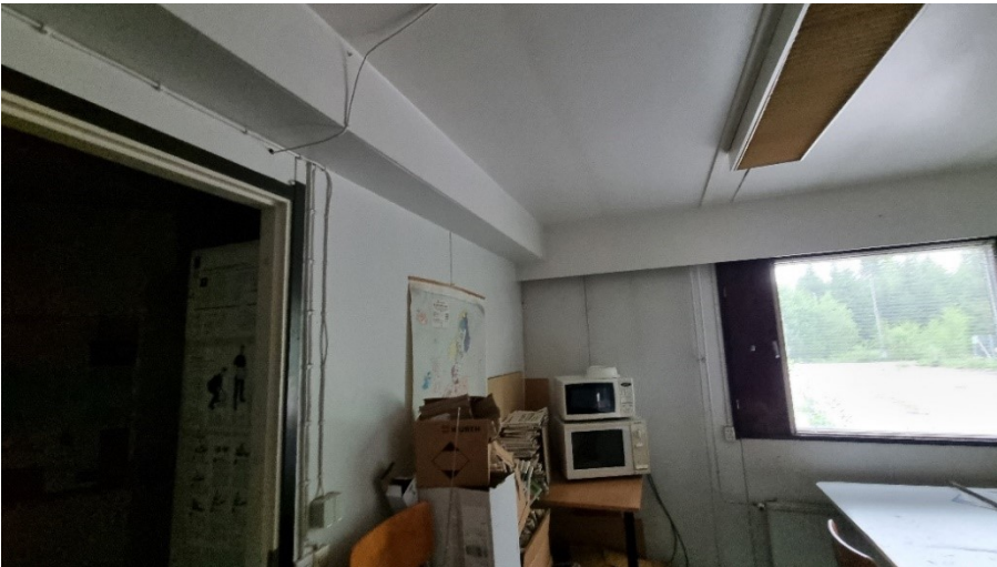
Kuvat 12 ja 13. Toimistorakennusta sisältä.
