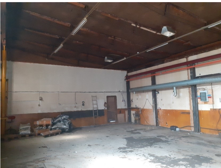
Kuva 7 Pohjoisemman hallin sisätilaa. Rakennuksessa ei ole ullakotilaa.
