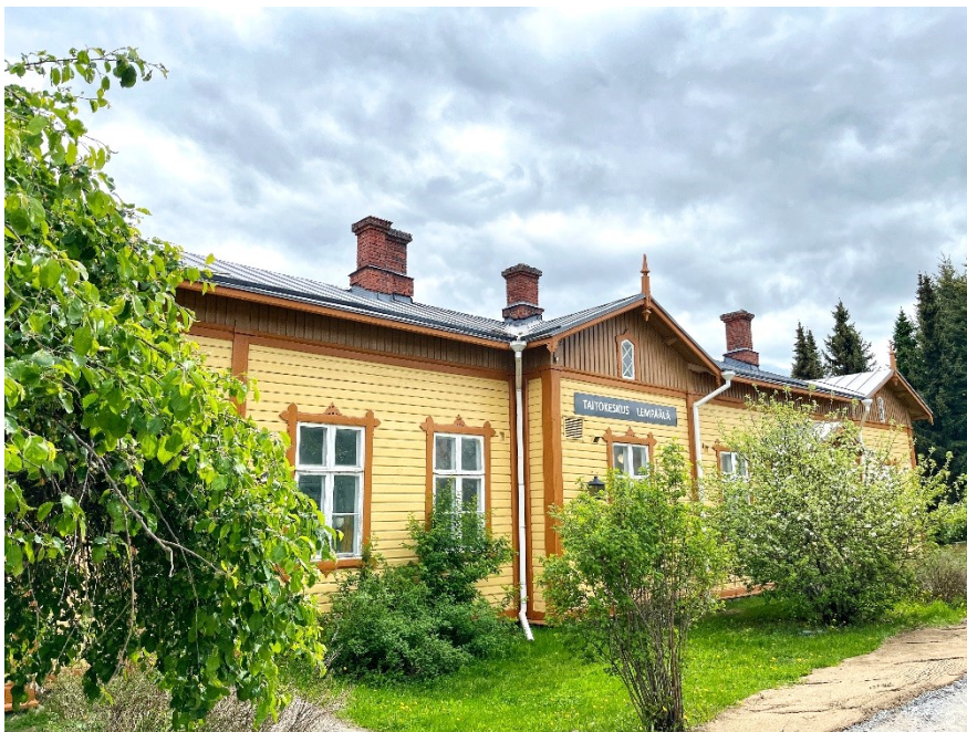
Asemarakennus sisäpihan puolelta (kuvattu 30.5.2023)
