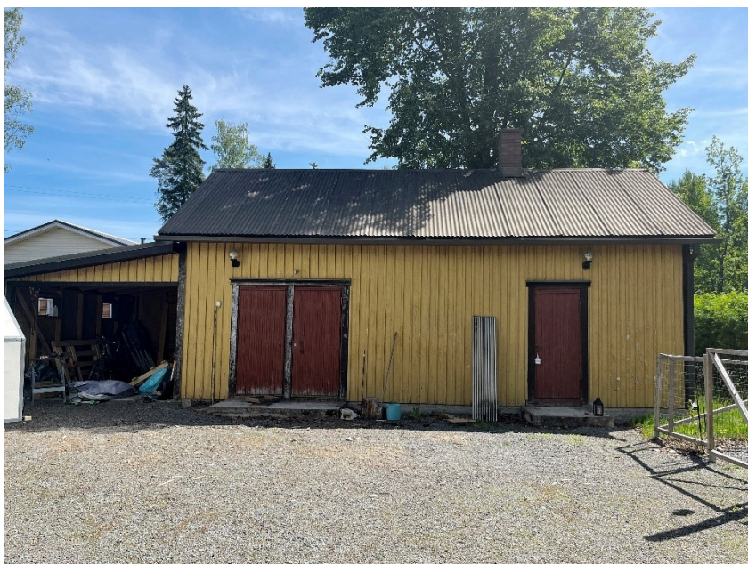
Kuva. Höytämöntien toinen purettava talousrakennus.
