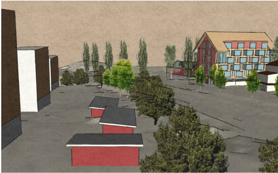
Kuva 3 3D tietokonemallinnuskuva Tampereentieltä ilmasta tarkasteltuna siten, että vasemmalla näkyvät kerrostalot Uotintie 4, 6 ja 8.
