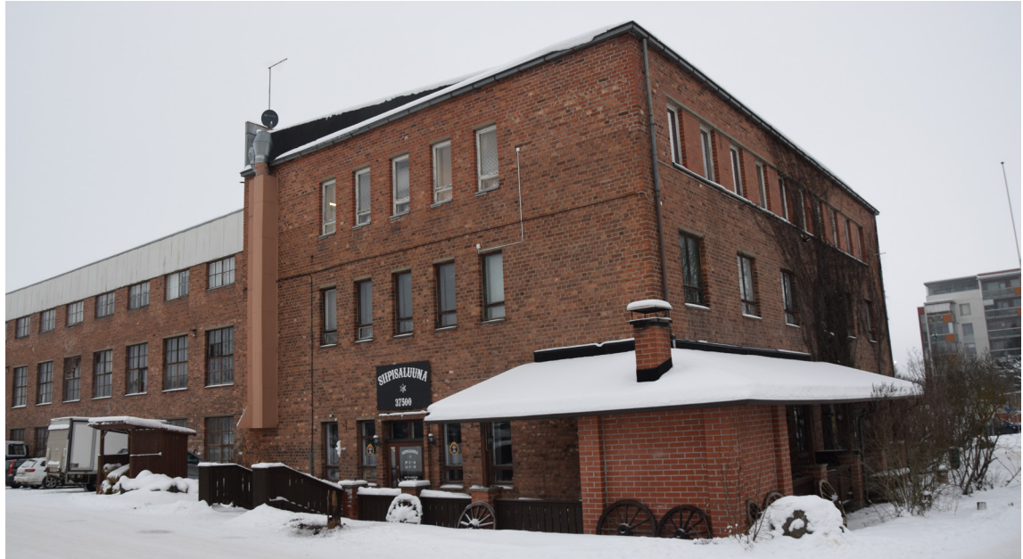
Kuva yllä: rakennus lounaiskul- masta kuvattuna.
