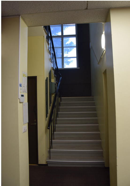
Kuva: Betoniporras on päällystetty laminaatilla.
