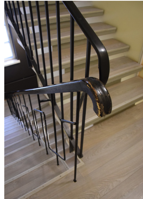
Kuva: Alaosan kaide lienee alkuperäinen; takorautaiset pinnat on taivutettu yksikertaiseen koristekuvioon ja käsijohde on maalattua puuta. Toisessa kerroksessa kaide vaihtuu modernimpaan teräspinnakaiteeseen.
