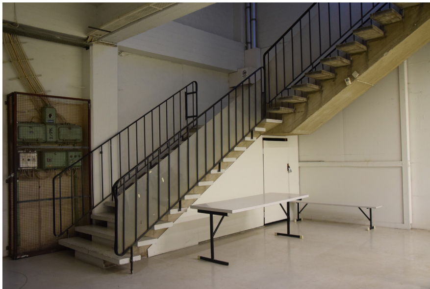
Kuva: Itäsiiven keskipalkillinen betoniporras rakennettiin vuonna 1969. Mustat pinnakaiteet ovat teräsrakenteiset, paarteet taivutettua lattaterästä. Alimpien syöksyjen kaiteissa on lisäksi plexilasisit.
