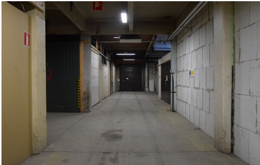
Kuva: Ensimmäisen kerroksen pohjoispää on jaettu varastoiksi ja työpajoiksi, väliseinät ovat Siporex-harkkoa tai rakennuslevyllä peitettyä puurunkoa. Pinnat ovat viimeistelemättömiä.
