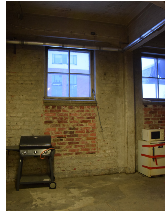
Kuva: Päätyseinän ikkuna-aukkojen alaosa on muurattu umpeen.
