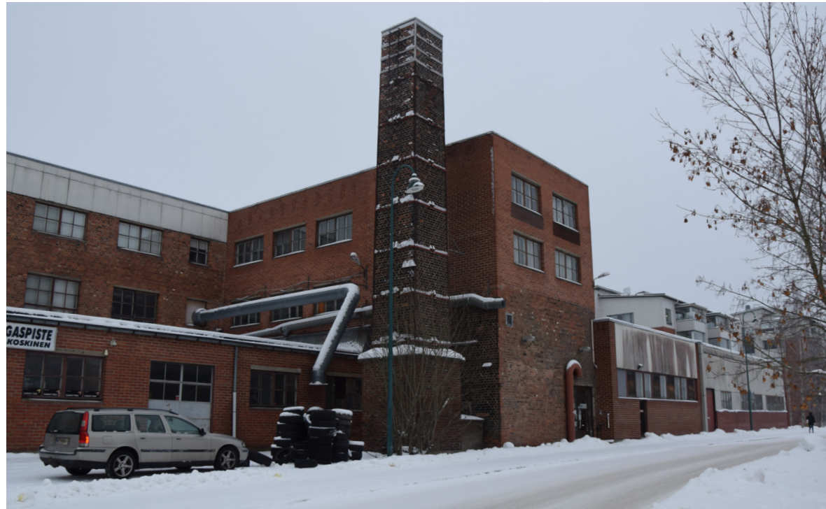
Kuva: Piipun viereisen kolmikerroksisen itäsiiven muurauksesta hahmottuvat alkuperäinen alaosa ja myöhemmin lisätyt yläkerrokset. Kuvan vasemmassa laidassa näkyy vuoden 1965 matala laajennusosa, joka mukailee alkupe- räisten osien arkkitehtuuria.
