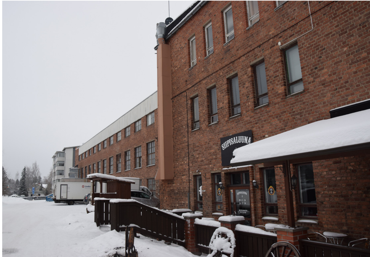
Kuva: Rakennuksen länsijulkisivua.
