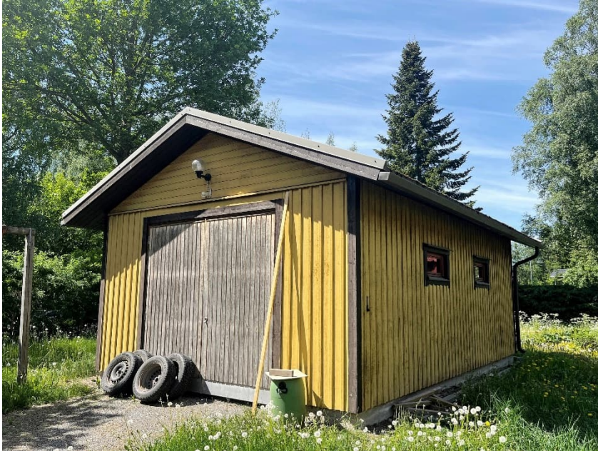
Kuva. Höytämöntien purettava talousrakennus.
